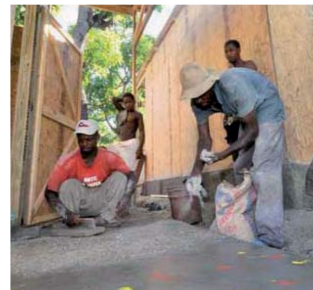
Die Häuser werden auf festen Betonsockeln verankert, an den Seitenwänden sorgen spezielle Streben für Stabilität. Auch das Dach wird sturmsicher montiert. Der Innenraum hat eine Fläche von 18 Quadratmetern, hinzu kommt eine fünf Quadratmeter große Veranda. An den Belüftungsöffnungen sind Moskitonetze installiert.
