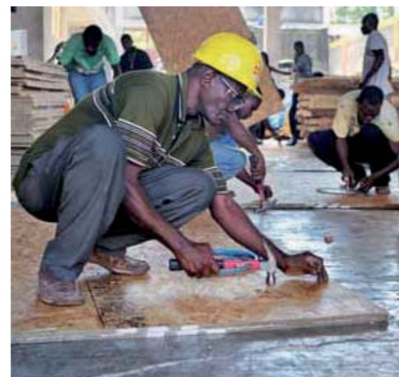
Im Auftrag des Arbeiter-Samariter-Bundes sorgen hier 20 Arbeiter dafür, dass hunderte Holzplatten und -balken passgenau angefertigt und lackiert werden. Das Material wurde zuvor auf dem lokalen Markt eingekauft.
