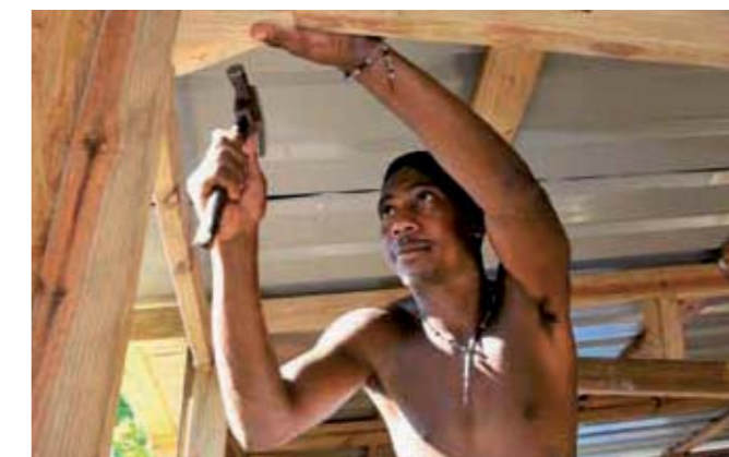
Aus den Platten und Balken entstehen pro Woche 40 stabile Häuser, die dort zusammenmontiert werden, wo die Menschen durch das Beben obdachlos geworden sind. Die künftigen Bewohner übernehmen während des Baus Hilfsarbeiten.
